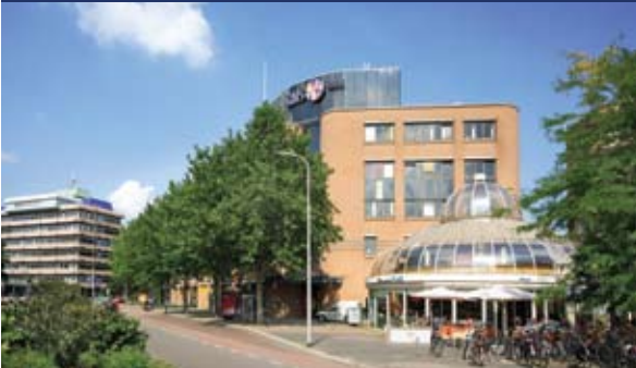
Winkelcentrum met kantoren. Ca. 12.300 m 2 . Multi tenant waaronder: Ahold, Lidl, SNS en Wibra.
