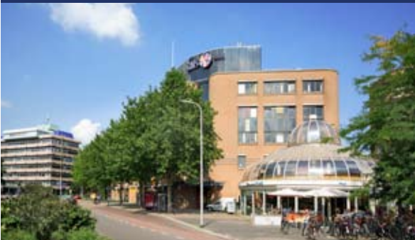
Winkelcentrum met kantoren. Ca. 12.300 m 2 . Multi tenant waaronder: Ahold, Lidl, SNS en Wibra.
